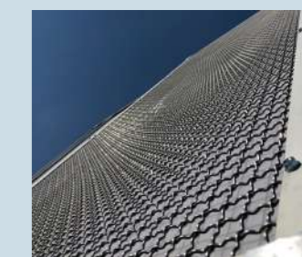
Griglia d'acciaio fissata sul lucernario piramidale
