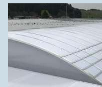
Fasce d'alluminio fissate sulla volta
