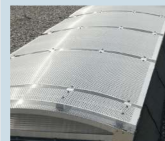
Lamiera perforata fissata sulla volta
